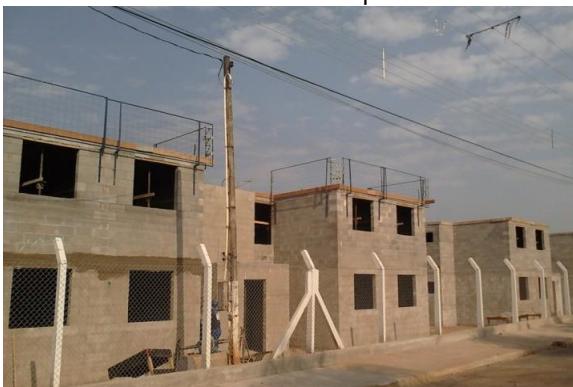
Figura 53: Obras do Conjunto Vertical em Taquaritinga/SP. Fonte: Website da Empresa.
