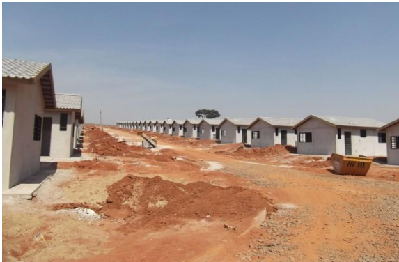
Figura 51: Obras do Conjunto em Lins/SP. Fonte: Website da Empresa.
