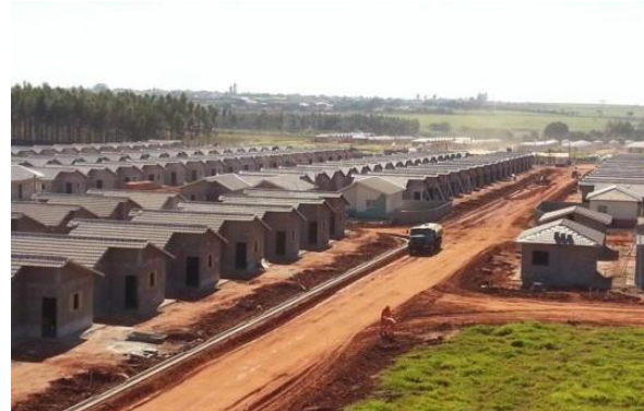
Figura 52: Obras do Conjunto em Mirassol/SP. Fonte: Website da Empresa.
