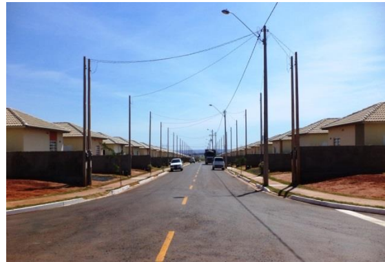
Figura 24: Vista Conjunto Luz da Esperança Fonte: Foto do autor
