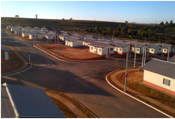
Figura 49: Obras do Conjunto em Botucatu/SP. Fonte: Website da Empresa.
