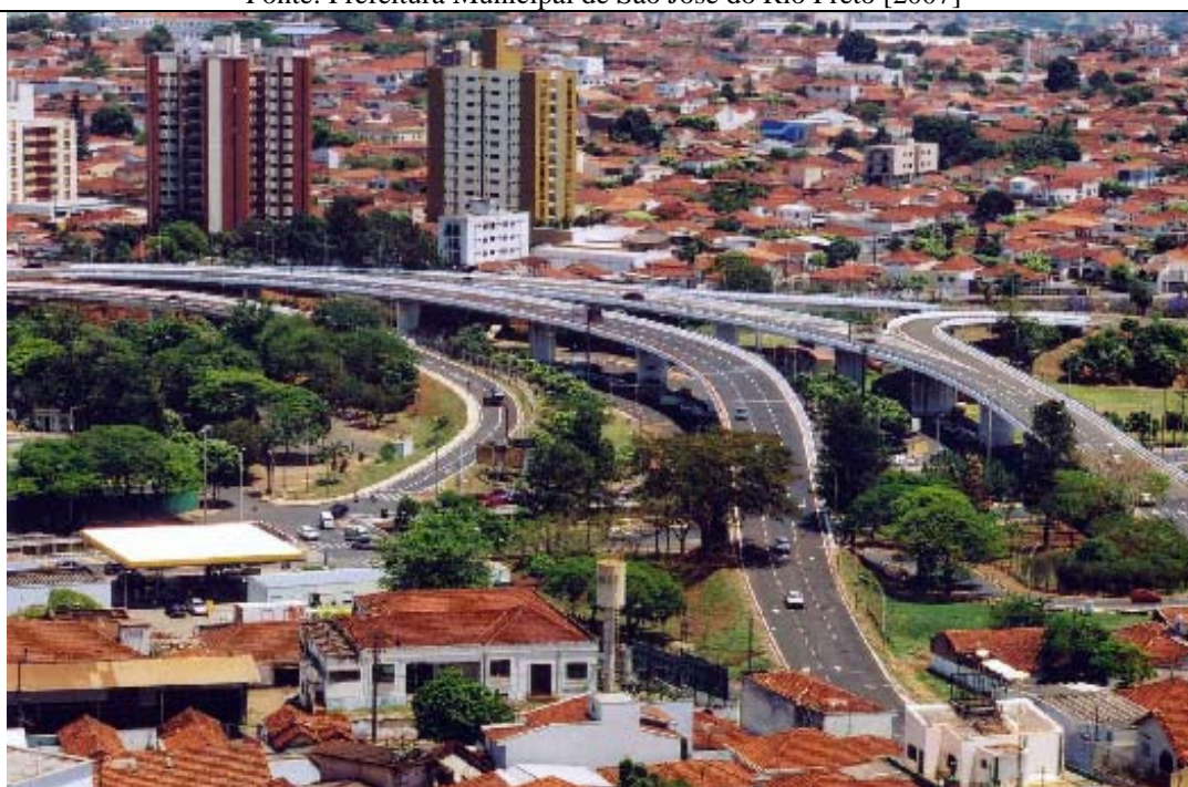
Figura 28 - Viaduto Jordão Reis Fonte: Prefeitura Municipal de São José do Rio Preto [2007]
