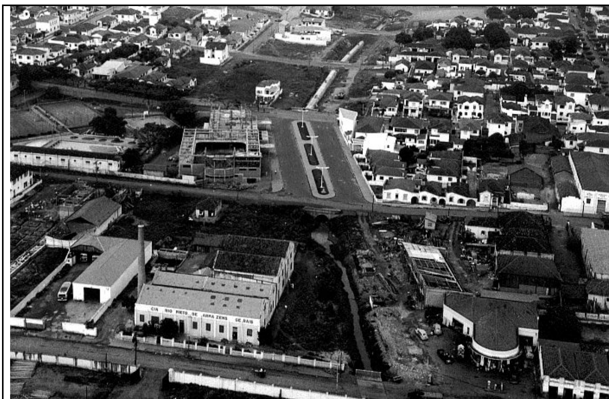
Figura 19 - Avenida Alberto Andaló em construção sobre o córrego Canela Fonte: Foto de Jaime Colagiovani [195 -]
